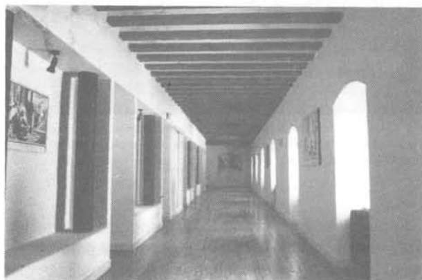
Fig. 4.—La nueva galería en el Ala N.
