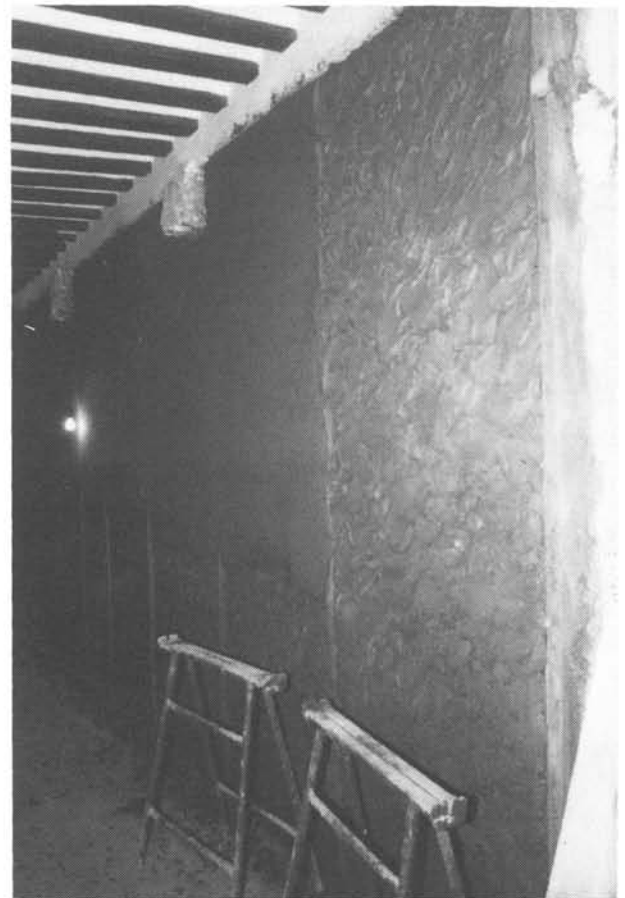
Fig. 7.—Aplicación de la capa final de mortero anticondensación, sobre los sectores independientes, en que se dividió el muro, tras su picado y saneado.
