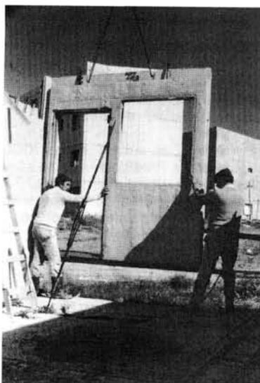
Montaje en obra de un panel prefabricado en una urbanización uruguaya.
