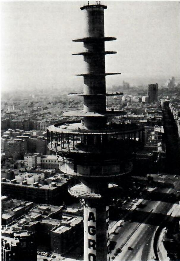
los anclajes, introducir las barras especiales de acero, y armar la losa.
