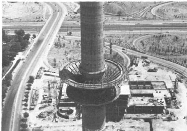
obra, de forma que con su capacidad de 2.000 kg en punta, con radio de 18 m y un giro de 360°, era suficiente.
