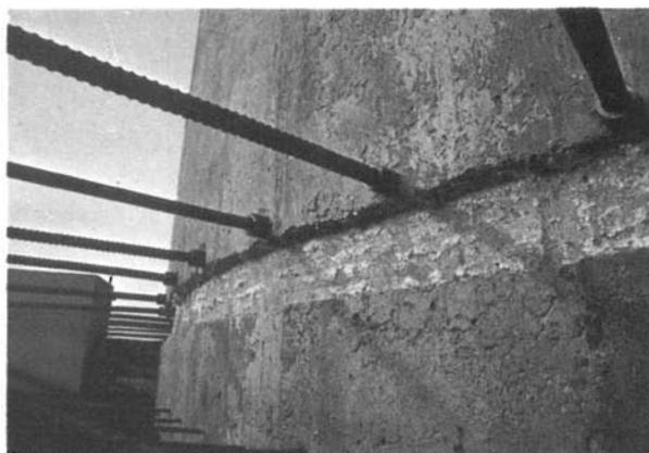
dial y su determinación se ha realizado conforme a la «Instrucción EH-80», empleándose un hormigón H-250 y acero AE-42.
