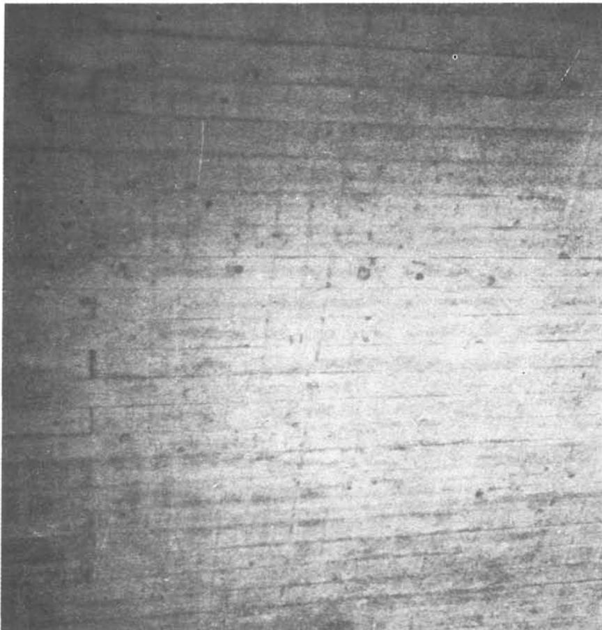
◀ La traza de la trama de armaduras es reproducida sobre la cara inferior de este techo en hormigón, por el óxido depositado por el agua en el fondo del encofrado antes del vertido del hormigón (defecto 1.12).
