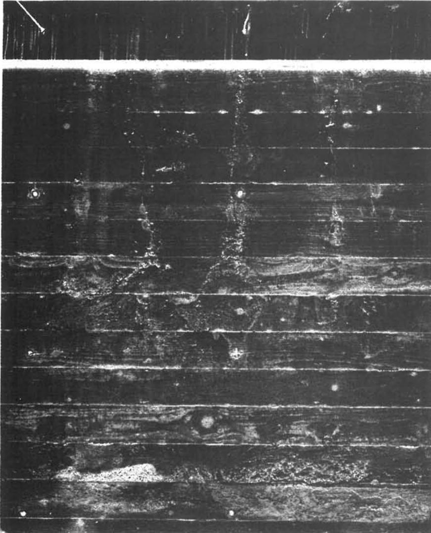
Exudación paralela a la pared del encofrado: Una importante cantidad de agua ha decantado y caminado, por sedimentación, hacia lo alto de la tongada de hormigón. Esto ha provocado, por una parte, variaciones de color (defecto 1.22) y por otra parte, la puesta en desnudo de los áridos, por erosión (defecto 2.3).
