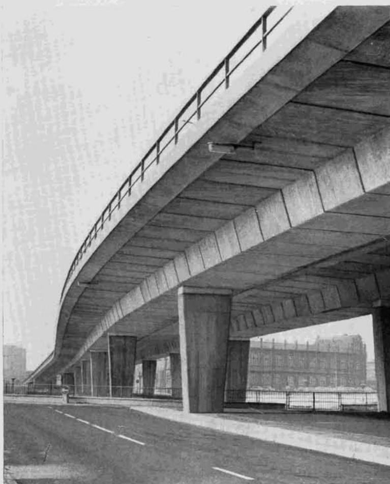
zos sobre los apoyos deslizantes, mientras el tablero está sometido a una alineación correcta. Las fuerzas tienen dos componentes: las debidas a la dilatación y contracción del tablero, y las ocasionadas por el rozamiento de los apoyos deslizantes. Ambos componentes son importantes. A continuación se discuten con más detalle.
