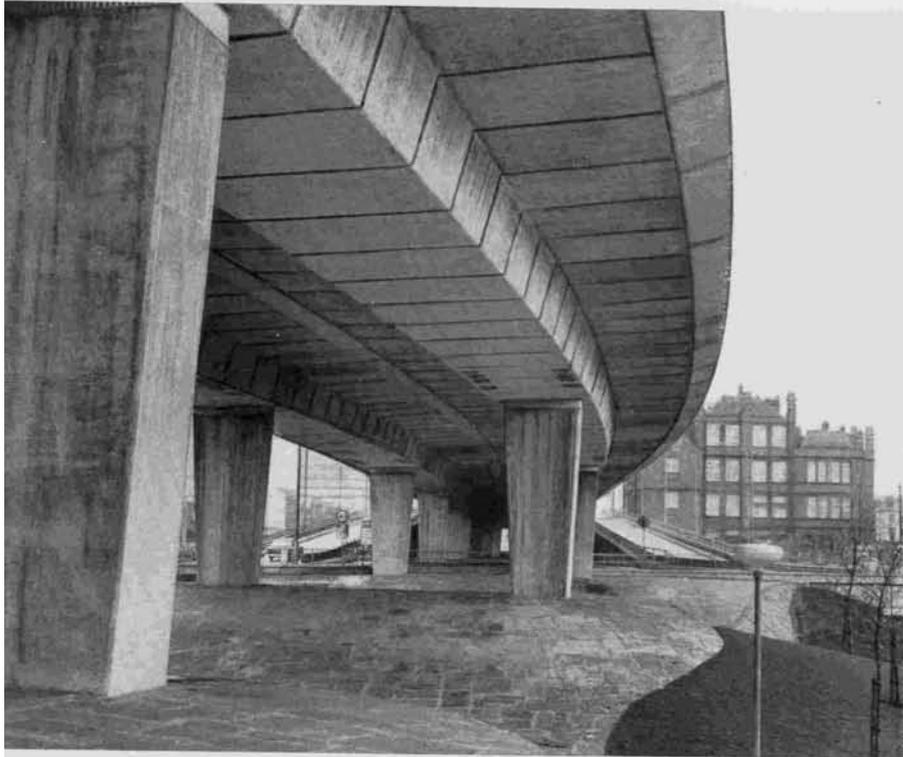
Con una carga que produzca un par máximo, como por ejemplo, una carga colocada totalmente sobre la mitad exterior de una sola calzada, hay una transferencia despreciable, al otro larguero, de las tensiones principales debidas al par; el esfuerzo cortante y el momento flector longitudinal son tan pequeños que la armadura sólo se hace necesaria para el estado final de carga.
