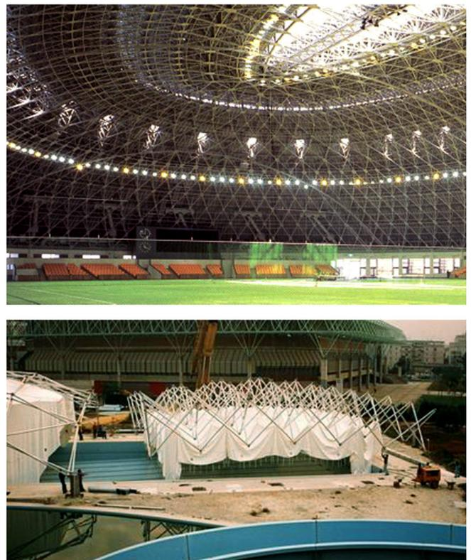
Figura 6. Arriba: Celosía espacial. Abajo: Félix Escrig: Cubierta desplegable para piscina, Sevilla. Fuente: *Fifty Years of Progress for Shell and Spatial Structures* (1).
