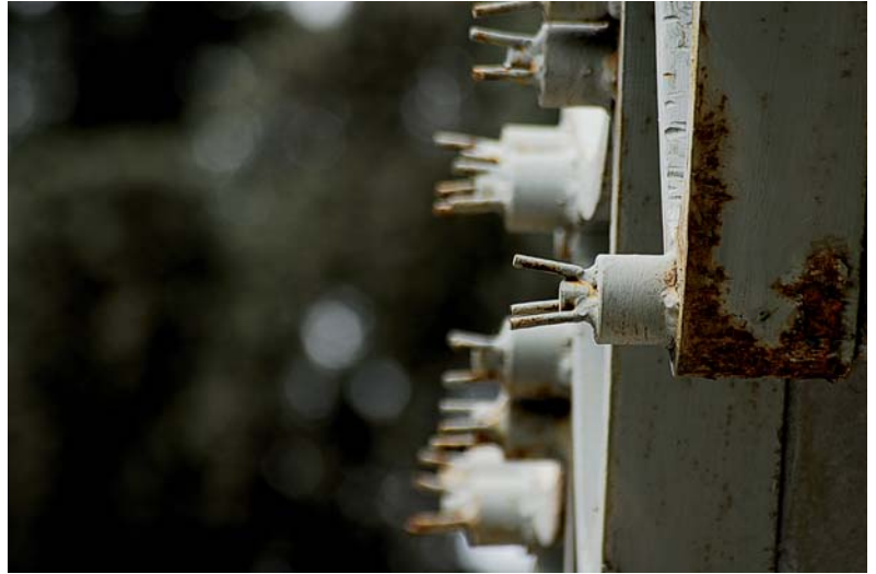
Figura 5. Anclaje Activo. Procedimientos Barredo. Marquesina del Centro de Estudios Hidrográficos.
