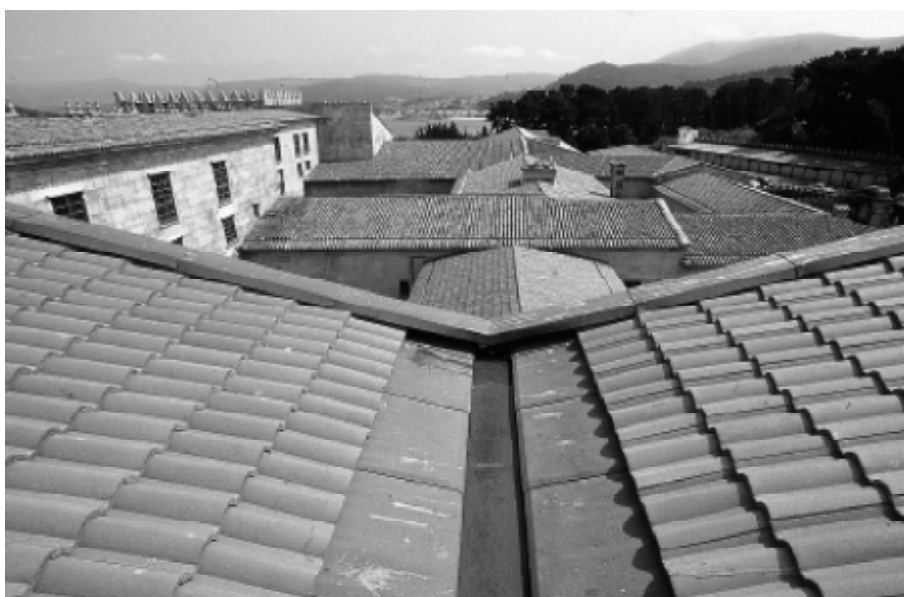
Figura 2. Rehabilitación del parador de Bayona con tejas de hormigón.
