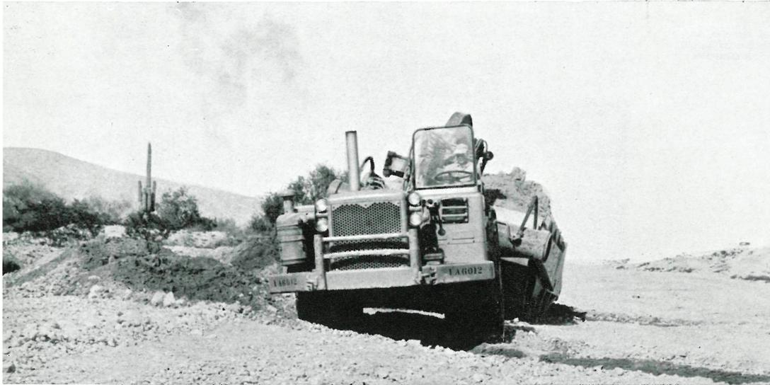
Unas zanjas cavadas en sentido oblicuo al de la marcha y convenientemente espaciadas hacen que el tractor y la tralla se fuerzan en direcciones opuestas.
