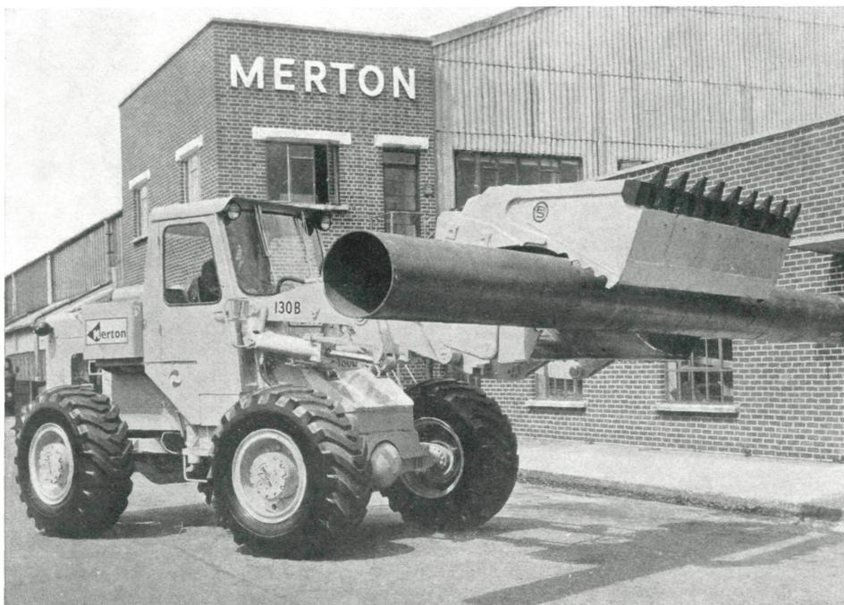
Se puede disponer actualmente de un nuevo tipo de cucharas de 1,5 m de capacidad. Una sección embisagrada, articulada por un sistema de combinación acodada y varillaje, permite efectuar el cierre de la quijada en un plano prácticamente paralelo al terreno, con lo que fácilmente se logra recoger pedruscos, maderas, secciones de hormigón y cualquier objeto de hasta 91 cm de diámetro.
