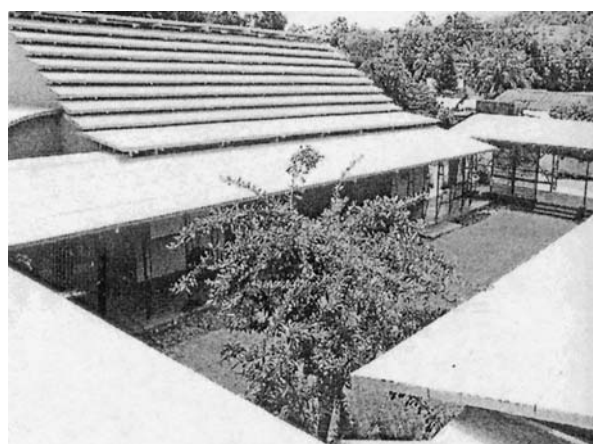
Figura 8.- Patio Central desde el techo del ECC. S. Sebastián de los Reyes. Estado Aragua (Venezuela).
