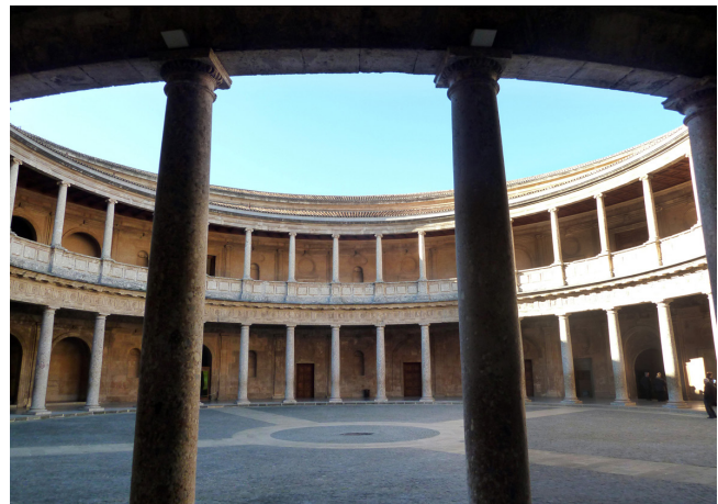
Figura 6. Patio circular del Palacio de Carlos V, articulando un doble pórtico de columnas dórico toscanas en el piso inferior y jónicas en el piso superior. (Fotografía de los autores).
