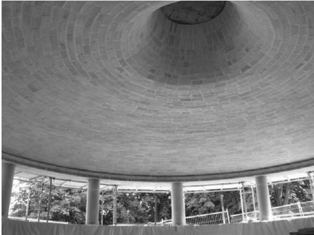
Figura A.- Bóveda Tabicada de 13 m de luz, 1,4 m de flecha y 15 cm de espesor.
