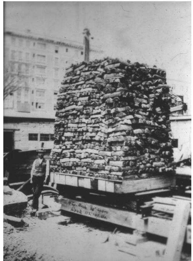
Figura 5.- Imagen de una prueba de carga en una bóveda tabicada.
