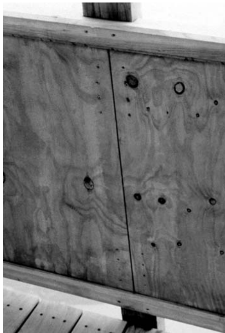
Figura 8. Unión de los tableros fenólicos que forman la barandilla.
