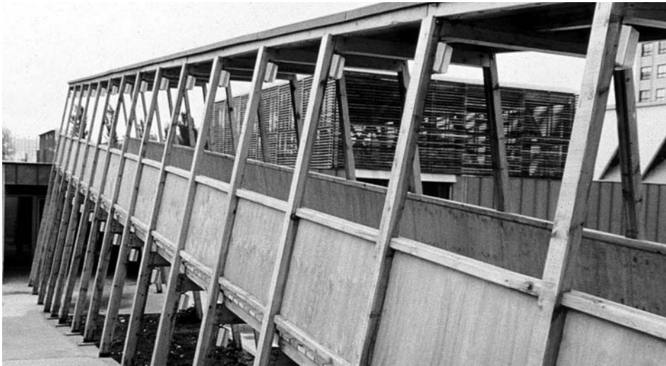
Figura 7. Perspectiva lateral de la pasarela.
