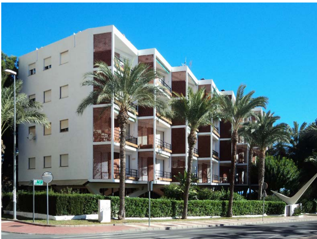
Figura 9. Edificio El Palmeral: perspectiva y estado actual. [Fuente: Archivo del Colegio de Arquitectos de Almería y fotografía de los autores].
