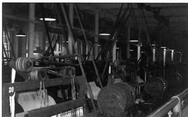
Figura 19.- Transmisión de energía desde las máquinas de vapor hasta la maquinaria de proceso por ejes, engranajes y correas en el complejo Boott Mill, Lowell, Ma, EEUU, 1821 (fuente: [http://www.bc.edu/bc\\_org/avp/cas/fnart](http://www.bc.edu/bc_org/avp/cas/fnart), Boston College, Fine Arts Department, "A Digital Archive of American Architecture, Prof. Jeffery Howe).
