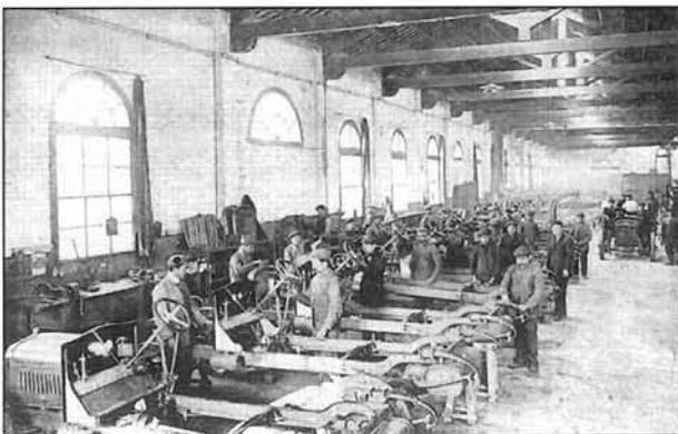
Figura 12.- Estructura de muros portantes de fábrica y celosías simples de madera en una fábrica de automóviles.
