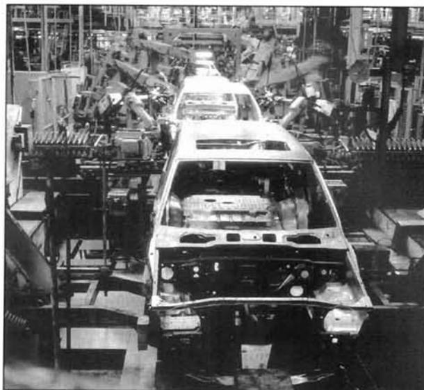
Figura 4.- Automatización y robotización de procesos en SEAT.
