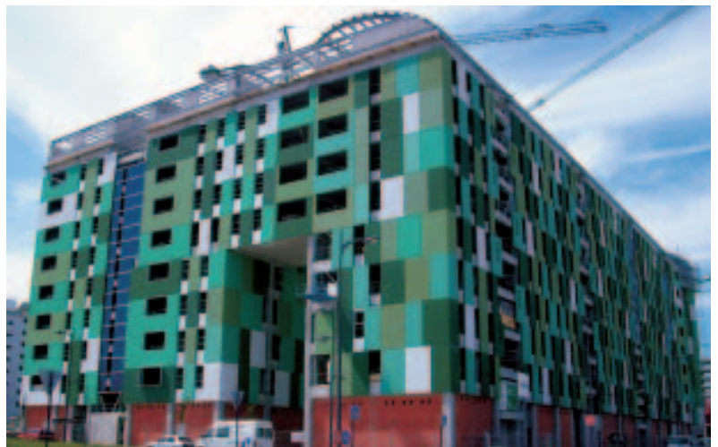
10. Estado actual de la obra.
