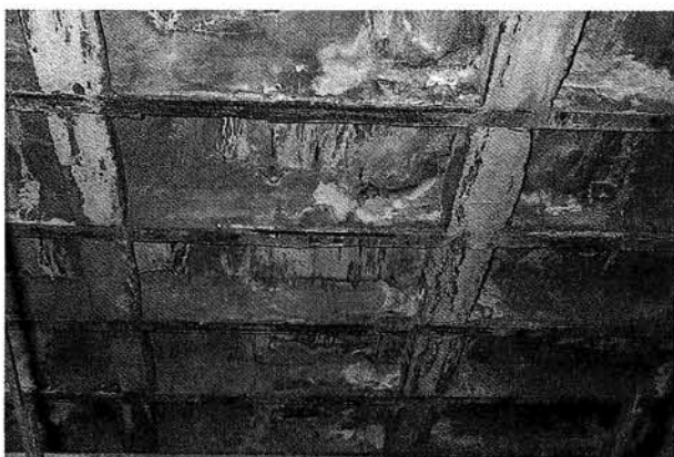
Foto 1.—Situación general del graderío del cuerpo volado.
