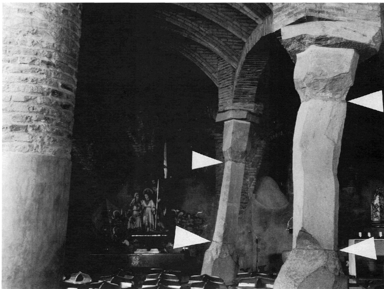
Fig. 16. Las juntas entre fustes y basas y capiteles son de plomo.
