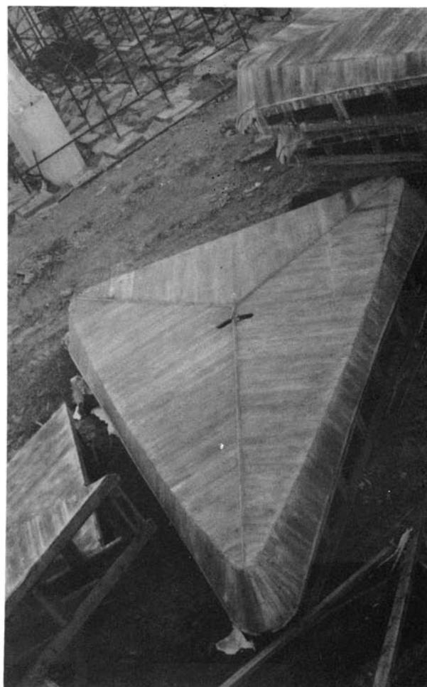
*"Quilla" para el encofrado en el punto del tablero.*
