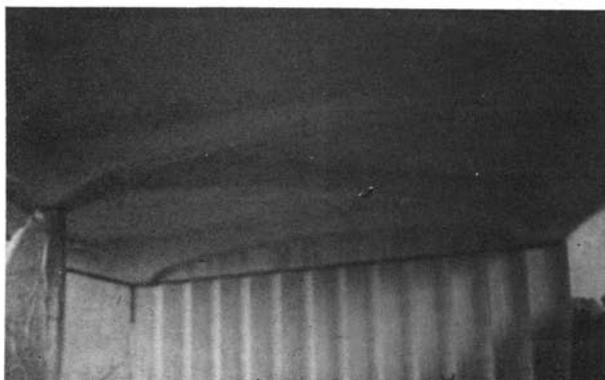
*Losa nervada (vista inferior) del tablero de uno de los tramos.*
