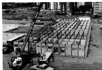
Etapa del montaje.
