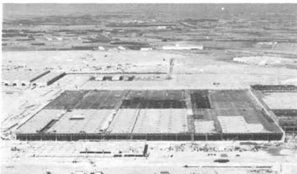
Zona de ensamblaje de la infraestructura y montaje en bruto. En primer plano la estructura a base de prefabricados de hormigón del Edificio Social.
