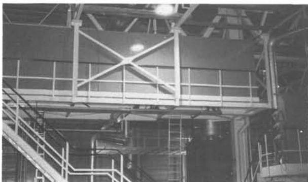
Construcción tipo estándar de una plataforma de maniobra colgante en la zona de los componentes de los chasis.
