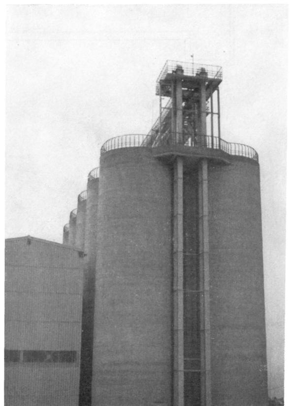
Dadas las particularidades del encofrado deslizante, el hormigón utilizado en la obra debía reunir una serie de condiciones especiales, sensiblemente distintas a las del hormigón que normalmente se emplea con encofrados fijos, por lo que fue objeto de numerosos estudios y ensayos hasta conseguir su perfecta adecuación.
