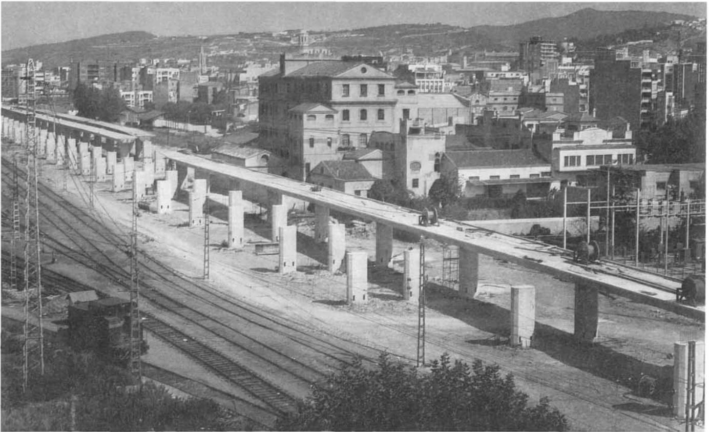
Fig. 7. La zona de la estación durante la construcción. Puede verse cómo la cimbra autoportante ha dejado sin realizar el tramo correspondiente a la bifurcación, que se haría posteriormente in situ.
