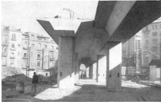
Fig. 12. Tramo VIII. En esta zona ambos dinteles están unidos a través de la losa. Durante la obra se utilizó para pasar el tráfico de un dintel al otro.
