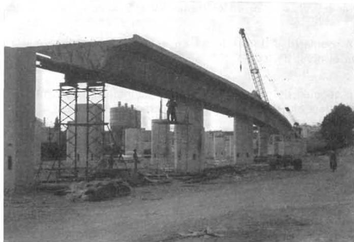
Fig. 8. Apoyo provisional para la iniciación de la construcción de un tramo en un punto intermedio del viaducto.
