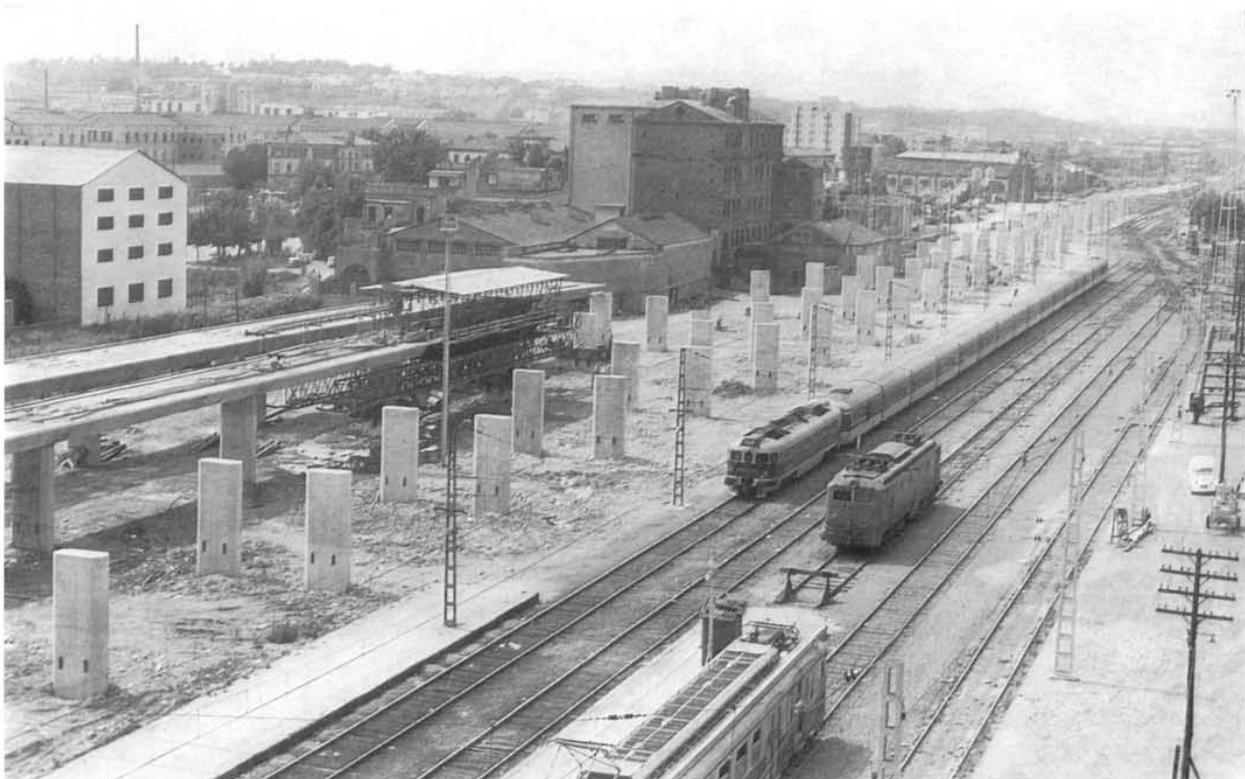
Colgada del pórtico se colocó una cinta transportadora móvil para el hormigonado del vano, con lo que se facilitó extraordinariamente esta operación.
