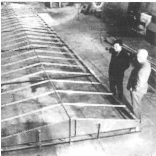
Fig. 18. Armadura para destilador solar de la Universidad de Glasgow.
