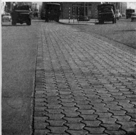
La distancia entre juntas de contracción es de 6 m. El firme se compone de una losa de hormigón en masa de 25 cm de espesor, que se apoya en una base granular de 15 cm de espesor, compactada al 90 % de la densidad Proctor modificada.
