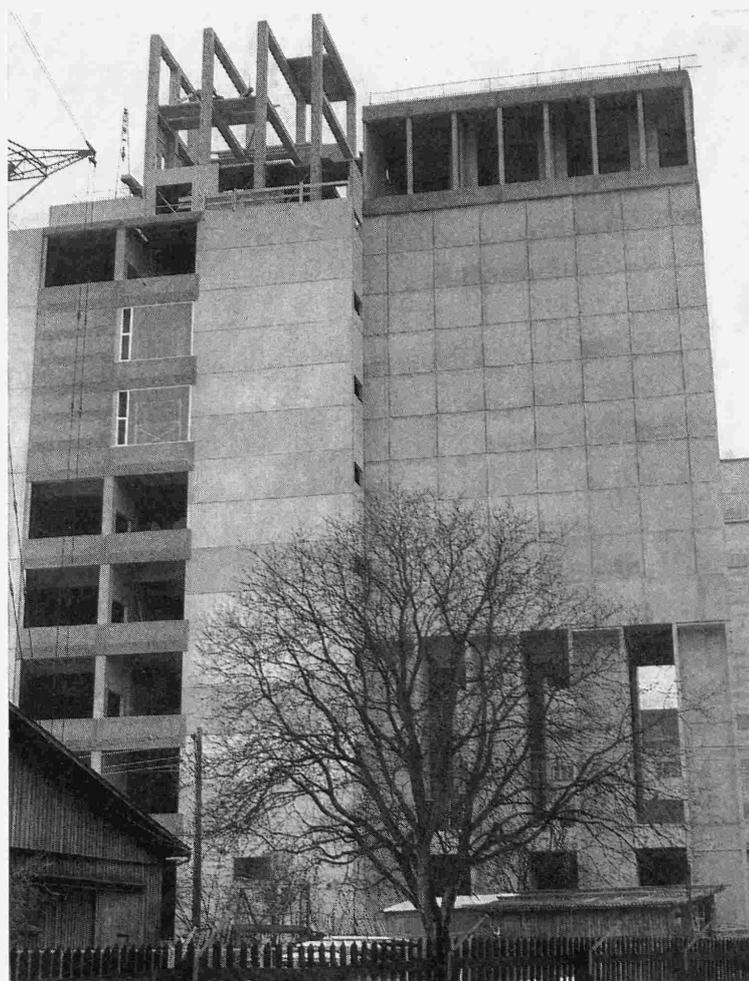
Nuevo tipo de silo prefabricado de hormigón, de cámaras múltiples,
