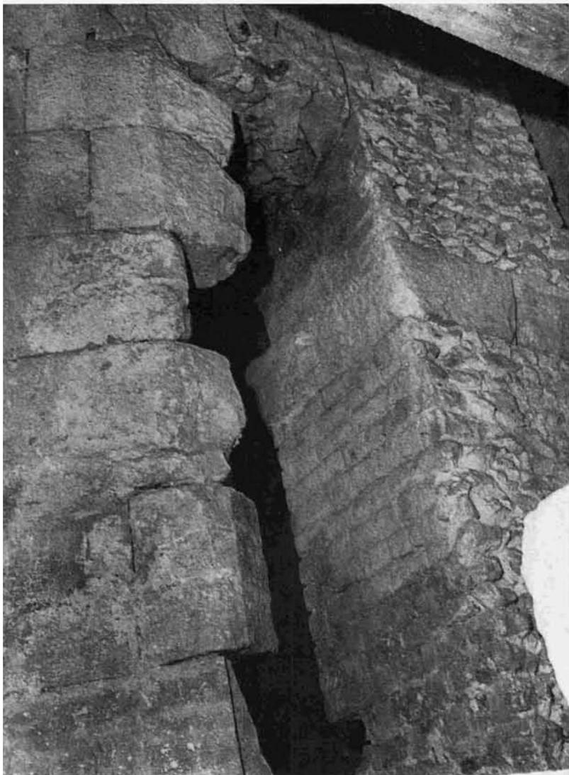
Detalle del pilar con paramento de arranque de bóvedas cortado de la fotografía anterior.
