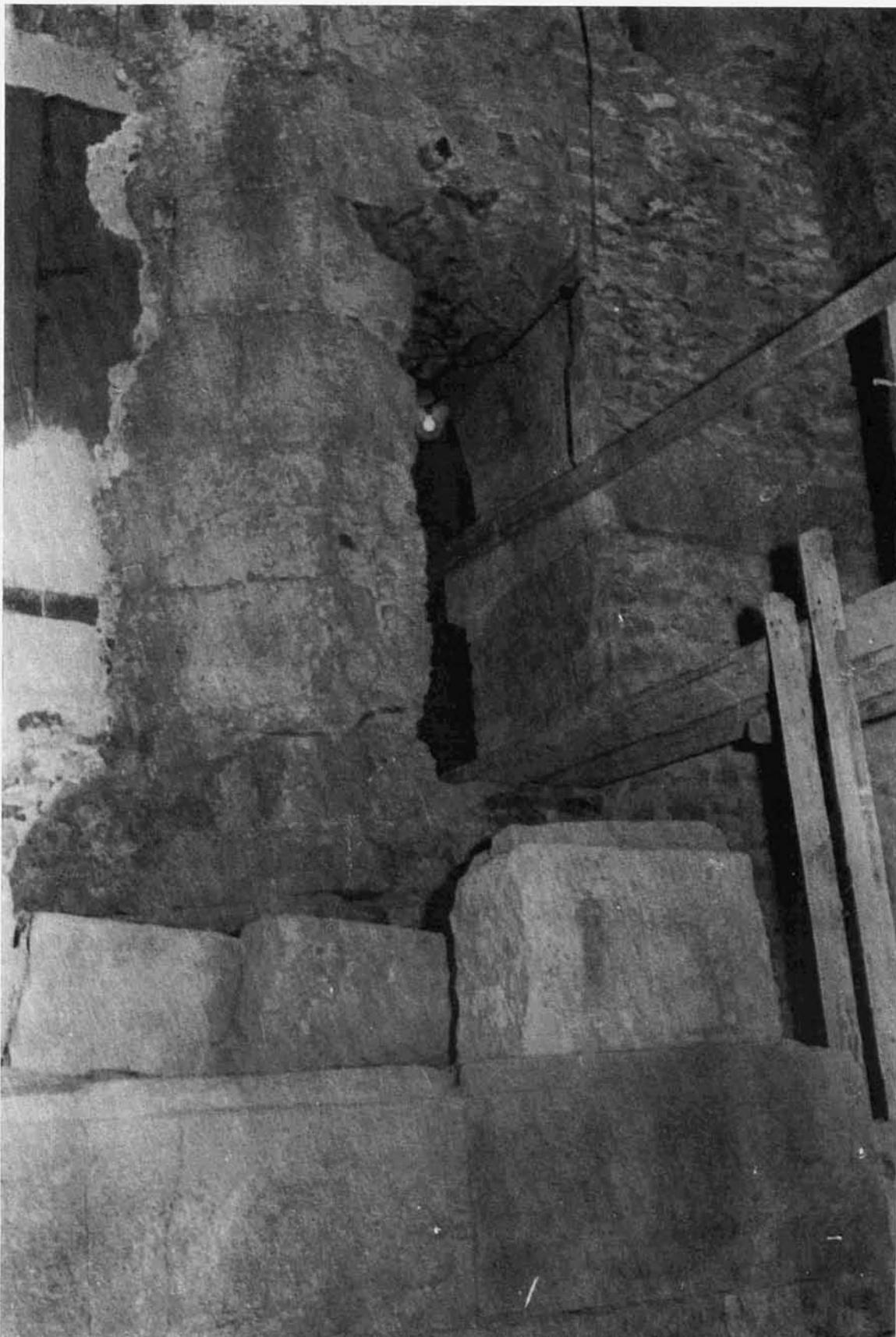
**Paramento frontal y corte por arranques de bóveda, hasta la caja por el plano del paramento transversal en acueducto II, visto desde el lado de fuera.**
