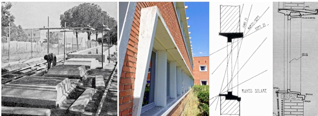
Figura 4. Protección solar en huecos mediante pieza prefabricada (7).
