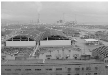
Figura 35. Vista de las naves después de retirados todos los arcos.
