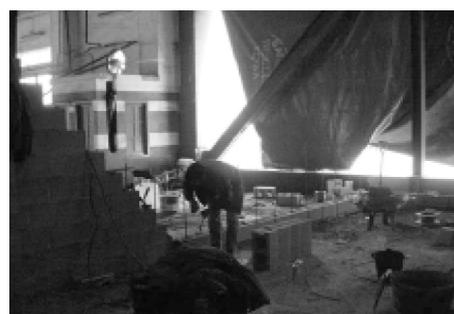
Figura 30. Construcción del murete de fachada.
