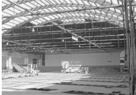
Figura 32. Vista de la nave durante los trabajos de retirada de las placas de fibrocemento de la cubierta.
