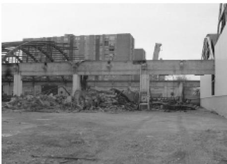
Figura 34. Vista de las jácenas longitudinales antes de ser cortadas.
