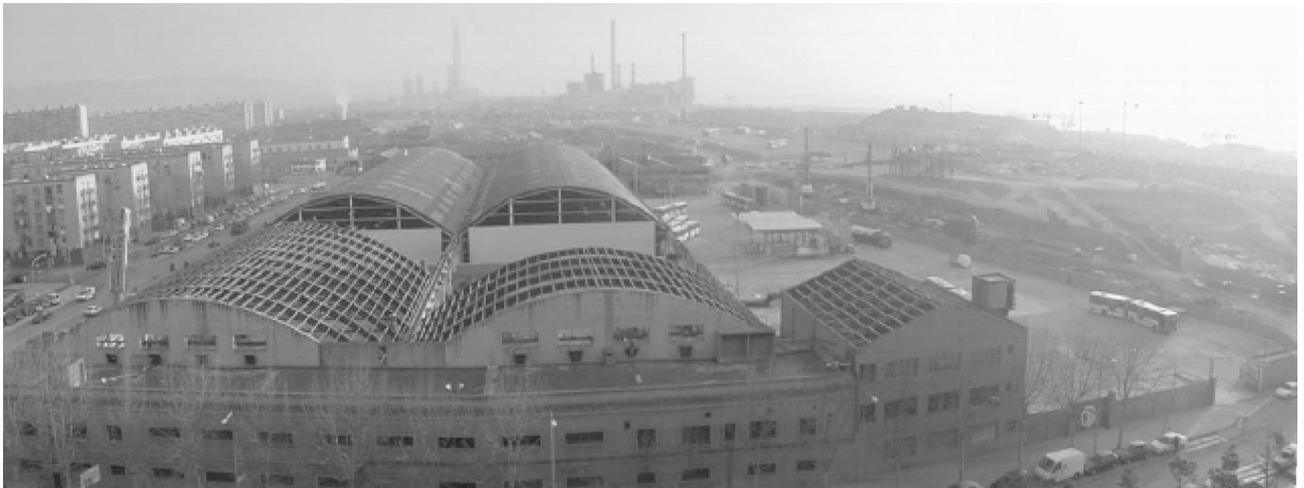
Figura 33. Vista exterior de las naves en pleno proceso de deconstrucción de correas y arcos de cubierta.
