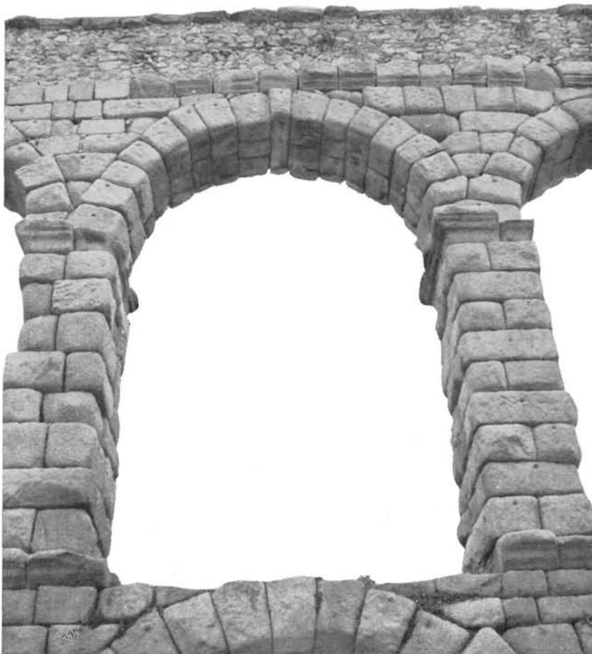
Arcada XXXVII. Acumulación de incorrecciones en pilar izquierdo. Obsérvese la colocación desordenada de sillares en cornisa superior y la desaparición de una zona en la inferior.
