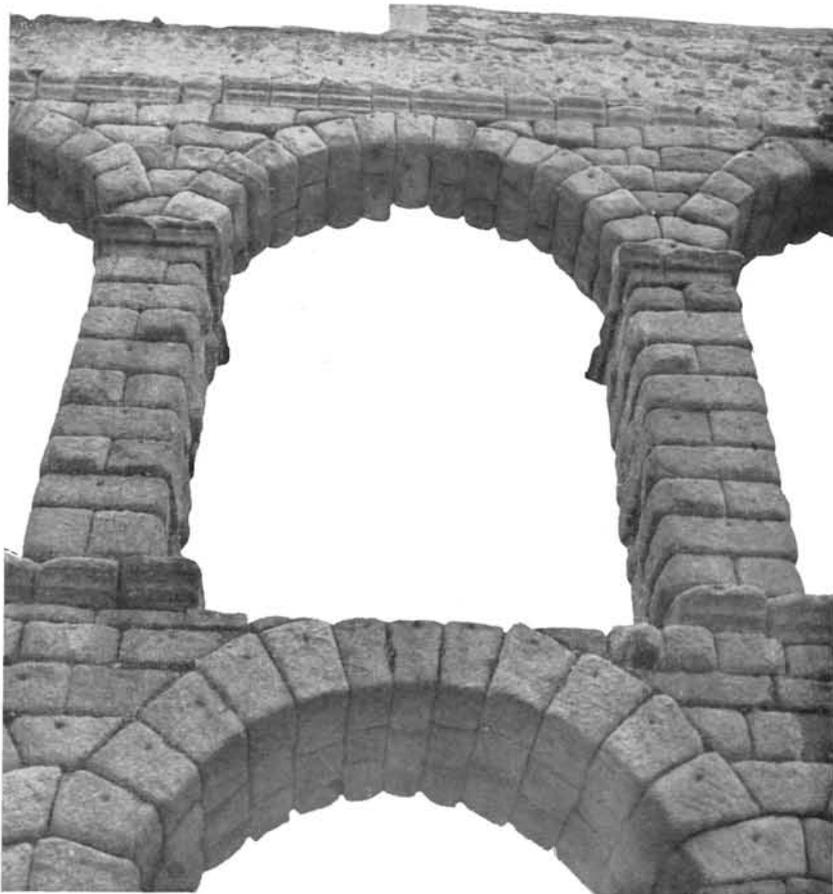
Arcada XXXII. Despiece correcto en bóvedas y pilares. Obsérvese la situación del agujero para introducción de la garra de elevación ajustado de un modo diferente en cada dovela. En la coronación se aprecia un escalonamiento de los muretes añadidos.
