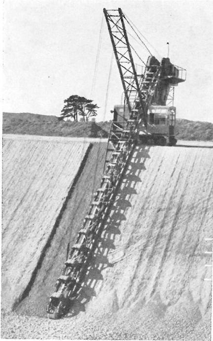
Máquinas que, pese a su complejidad, suelen ser de fácil manejo por un solo operario y que están destinadas a la extracción mecánica de arcillas, gravas, arena y materiales sueltos.
