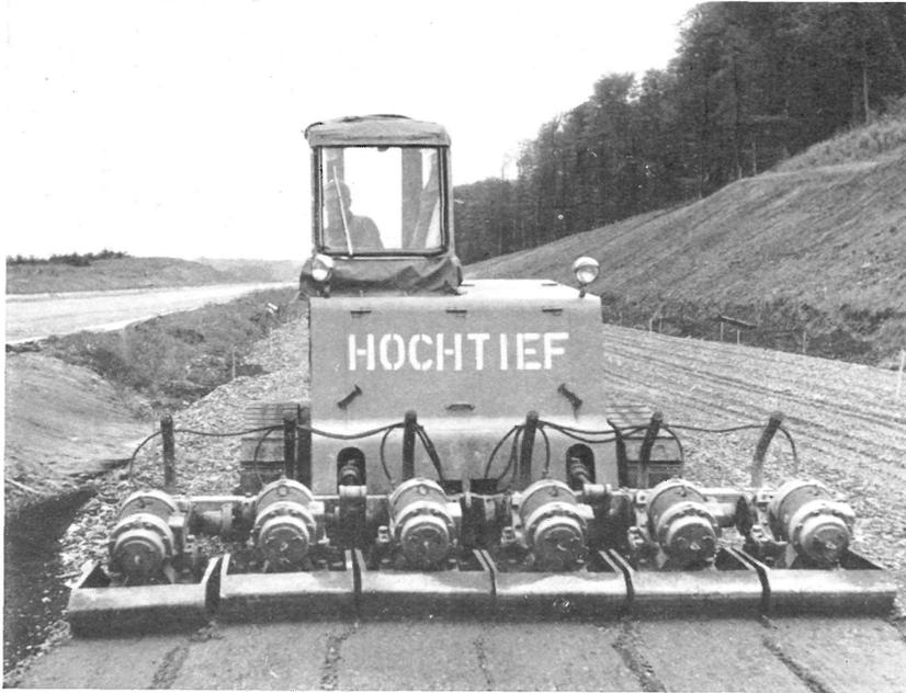
Normalmente, son vehículos automotrices, que soportan un bastidor delantero o central en el que van situadas un número variable de placas independientes, cada una de las cuales está dotada de un vibrador individual.
