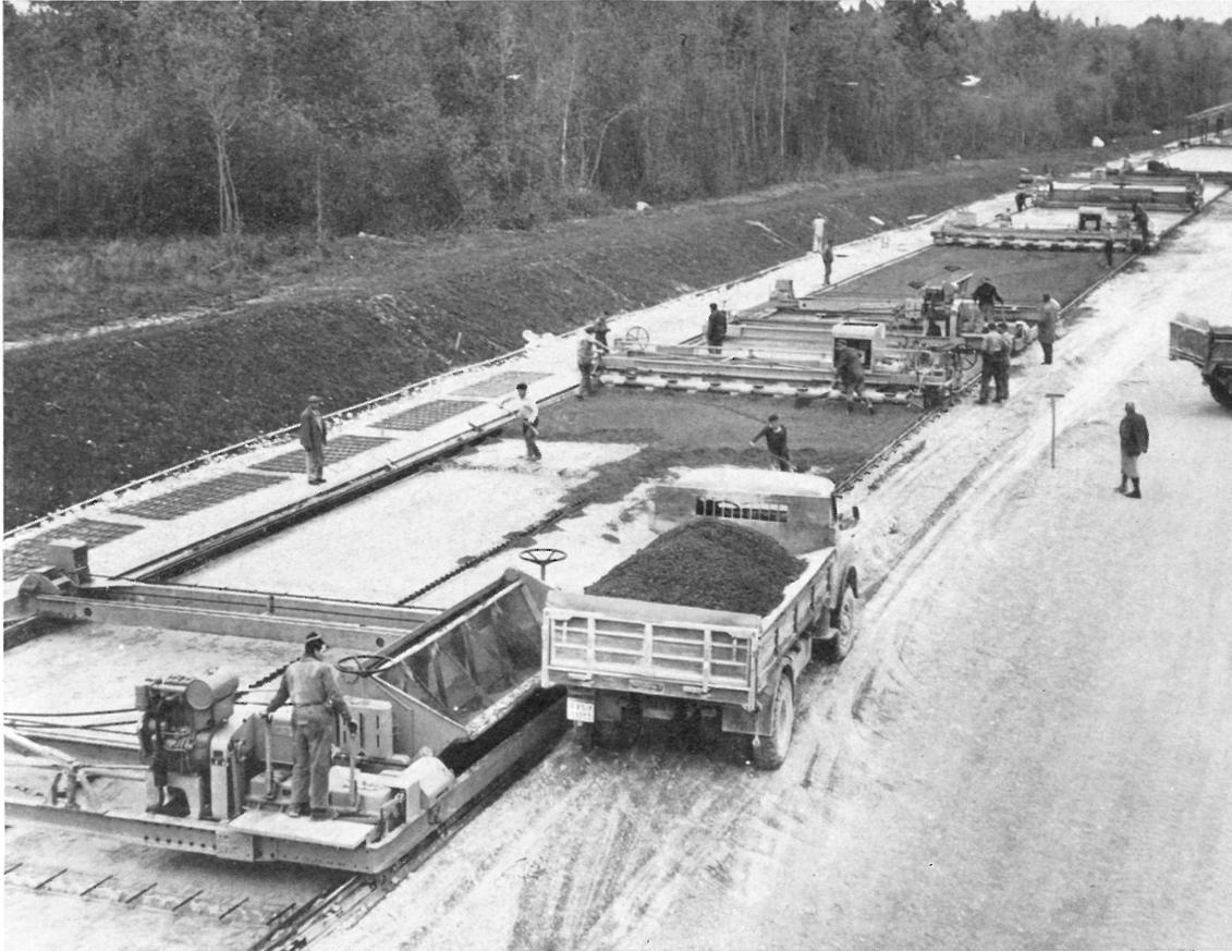
**Tren de hormigonado para firmes de carretera, que permite pavimentar según proceso continuo de producción industrial.**
