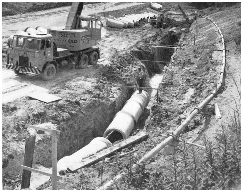
Se ha dispuesto en la autopista y sus intersecciones un sistema de subdrenaje muy completo. Véase en la fotografía la colocación en zanja de un tubo colector para la evacuación de las aguas infiltradas y de las superficies que se recogen en la berma hundida de las secciones en desmonte.
