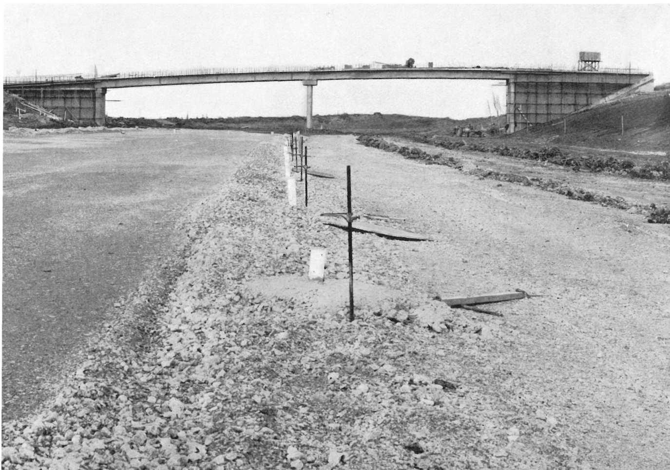
Para el cruce de carreteras a distinto nivel y reposición de servidumbres es preciso construir 46 estructuras. La fotografía muestra una pasarela de peatones.
