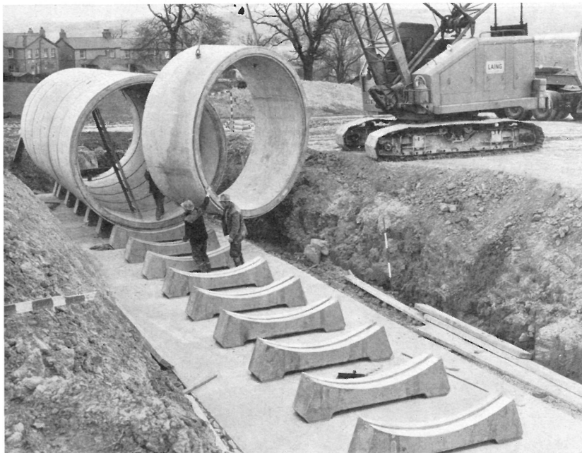
Montaje de tubería de hormigón vibrado, de 3 m de diámetro interior, para un paso de peatones bajo la autopista.
