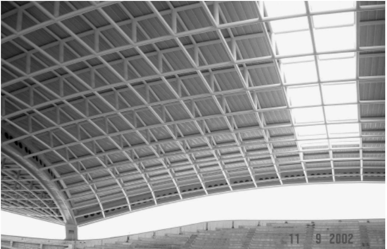
Figura 25.- Aspecto del interior en donde se aprecia uno de los cuatro soportes.
