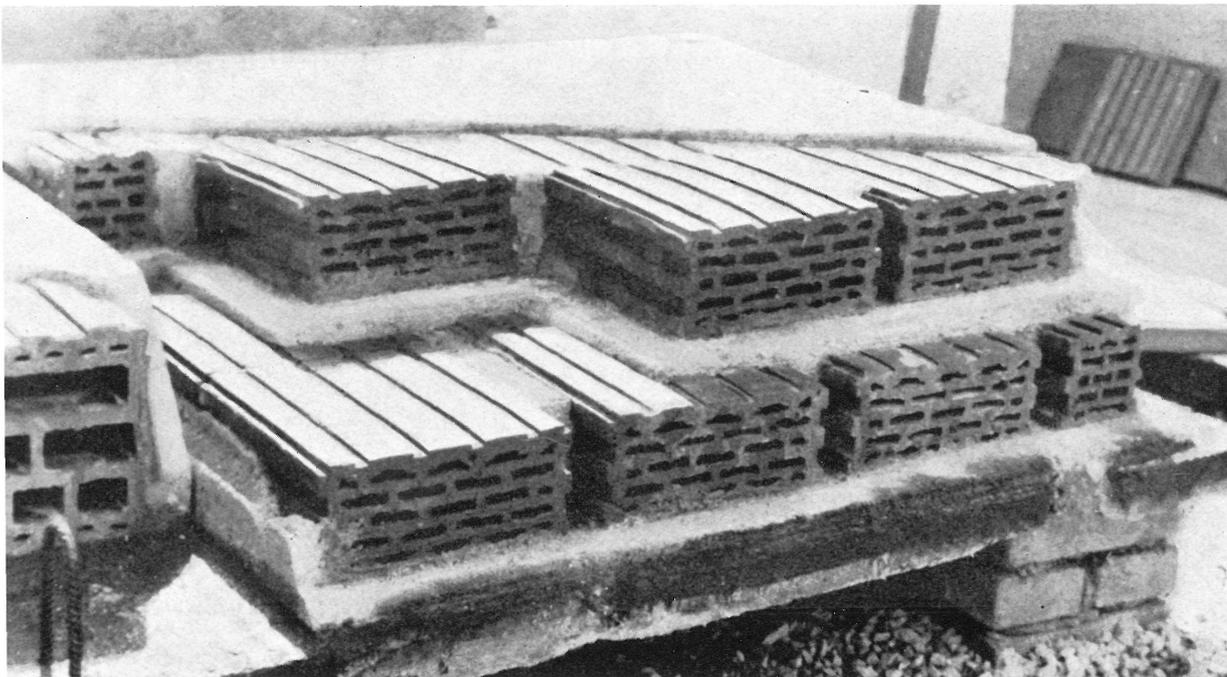
Panel de cerramiento prefabricado, a base de piezas cerámicas huecas de paredes delgadas, colocadas sobre un basamento de hormigón armado y dispuestas en dos estratos separados por capas de mortero de cemento. El espesor total del panel es de 30 cm. Las dimensiones normalizadas son  $240 \times 260$ , o bien  $120 \times 60$  cm. Su peso es de  $455 \text{ kg/m}^2$ .
