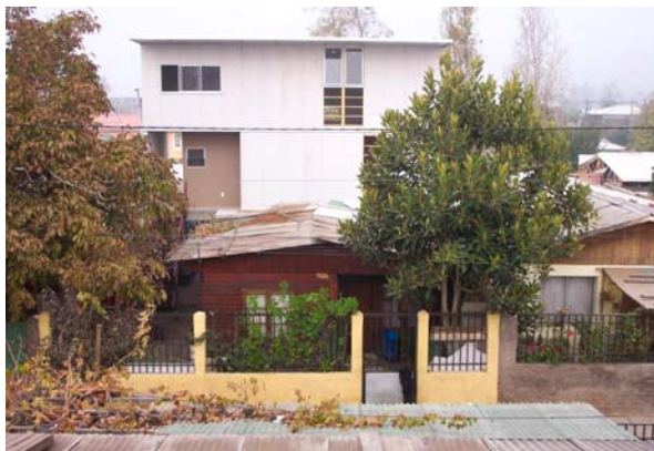
Figura 7.- Proyecto piloto construido en el fondo del lote.
