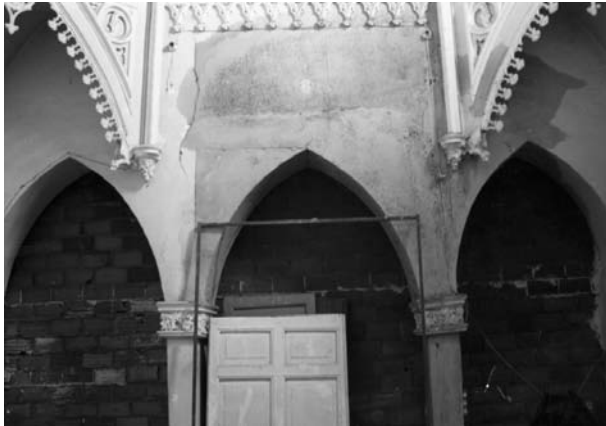
Figura 7.- Falsos pilares con capitel en el paño oeste.
