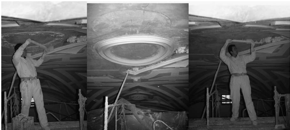
Fotos 1, 2 y 3.- Realización de los trabajos de aterrajado in situ.
