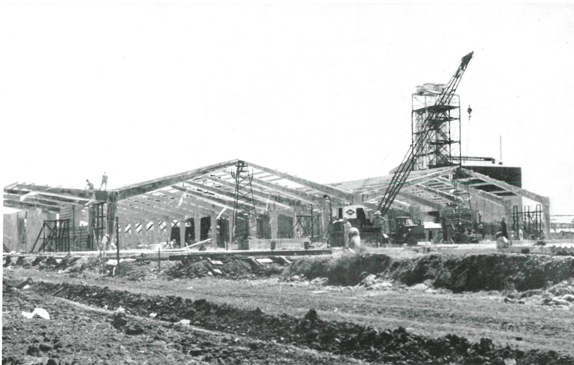
Nivelación del terreno.
