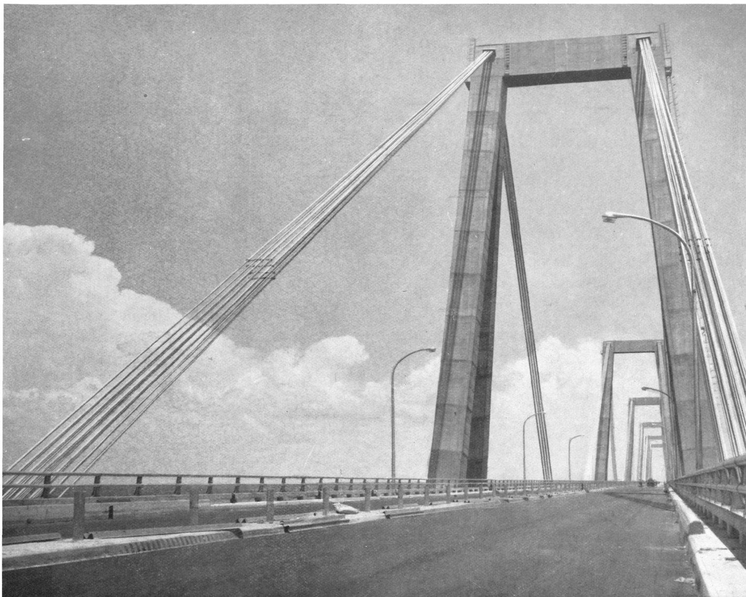
El puente terminado.
