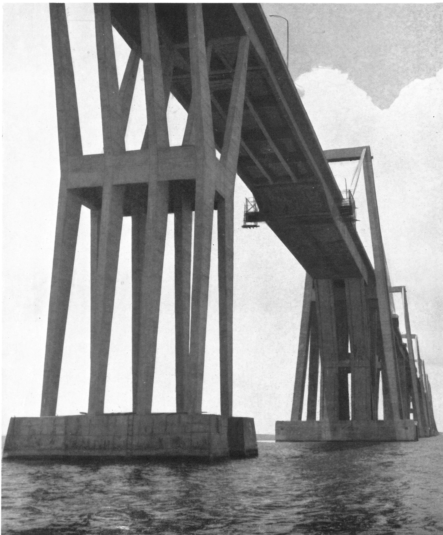
Vista próxima de una pila.
