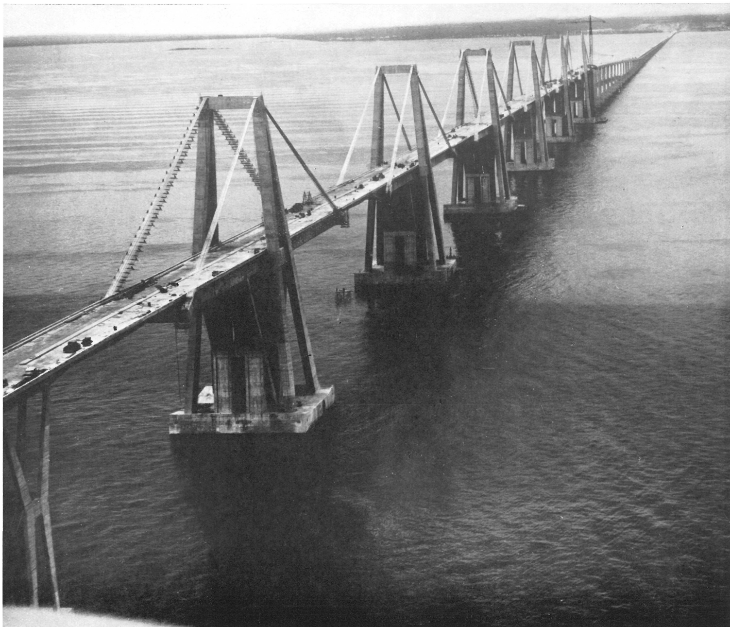
Tramos principales del puente.
