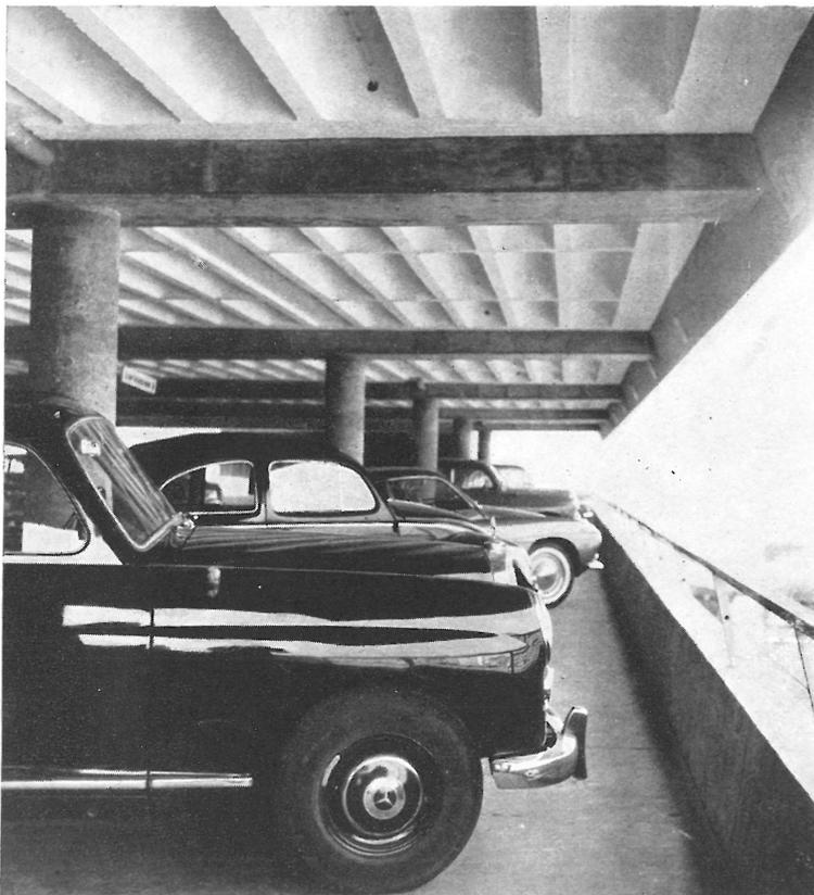
Hay huecos para ventilación y se procura la debida calefacción por aire caliente en la rampa de salida. La extracción de aire viciado se efectúa por ventiladores expulsores hacia la parte superior.
