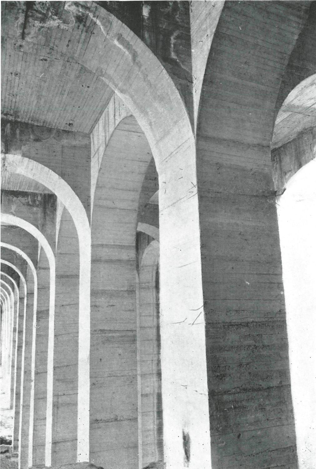
La obra habría de ser revestida después con un plaqueado de piedra, y bastaba que la pieza de clave resaltase sobre el resto del paramento para suprimir el mal efecto que pudiese hacer la junta visible en clave.
