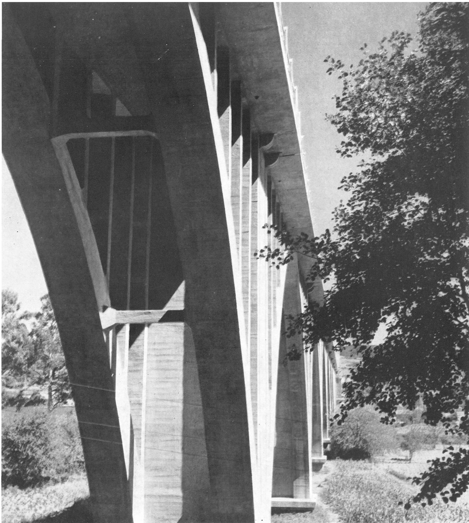
La directriz, que en un principio se adoptó parabólica, se rebajó después 20 centímetros en los riñones, con objeto de encajar mejor el funicular de pesos propios, sin que por este pequeño cambio de forma haya perdido el arco nada de su belleza.
