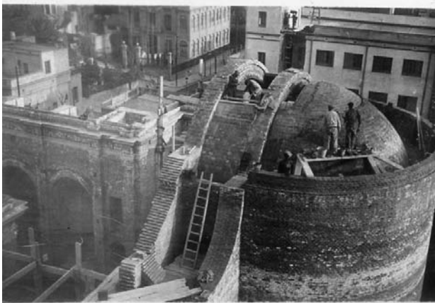
Figura 9.- La iglesia de San Miguel de los Santos de Barcelona en proceso de construcción.
