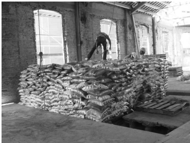
Figura 6.- Último escalón de la prueba de carga realizada sobre una bóveda de Ca l'Aranyó.
