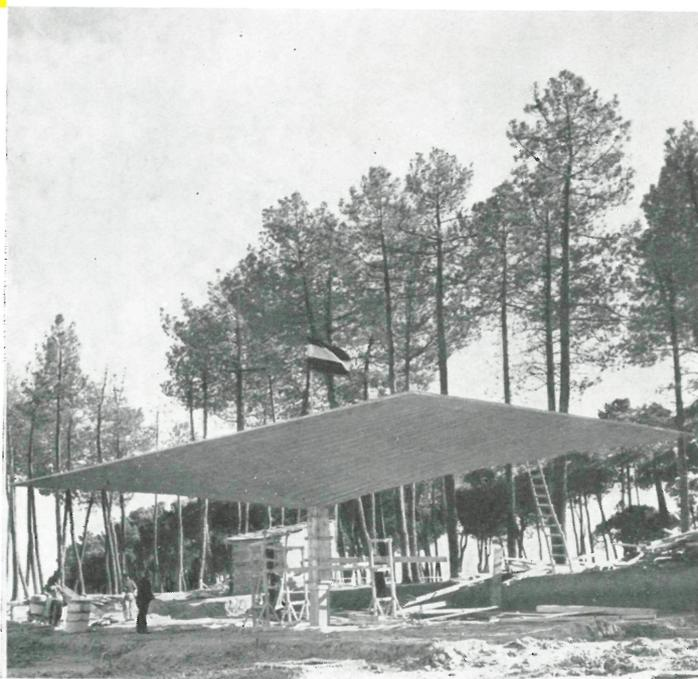
Las dimensiones de la obra, junto a la sobrecarga considerada, de  $150 \text{ kg/m}^2$ , y el empuje de viento previsto, de  $100 \text{ kg/m}^2$ , han permitido llegar a una solución laminar de 4 cm de espesor, dimensión que ha sido ampliada a 5 cm en los bordes para conseguir el recubrimiento necesario del paquete de armaduras extremas.
