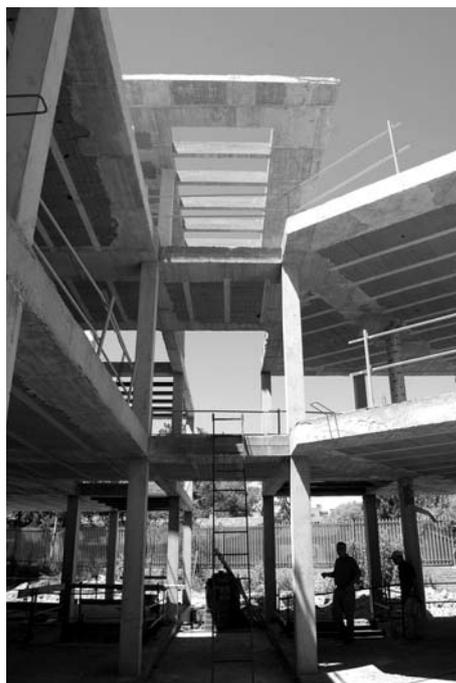
*Estructura realizada con hormigón de árido reciclado. Proyecto Tato.*
