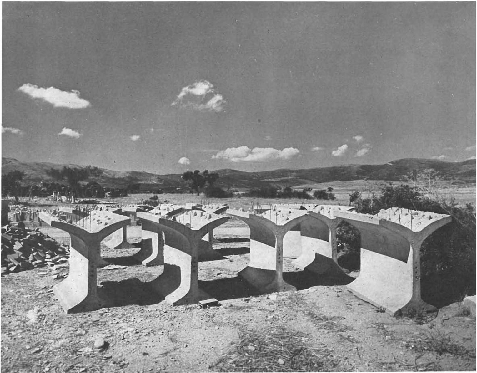
Finalmente se ensayó una quinta solución. Las piezas presentan unos rigidizadores de alma con unos orificios transversales. Las vigas se colocan, unas junto a otras, enfrentándose los rigidizadores.
