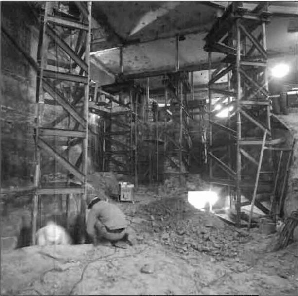
*Excavación del aljibe e inicio del gran pórtico de hormigón. Boca del escenario adelantada.*
