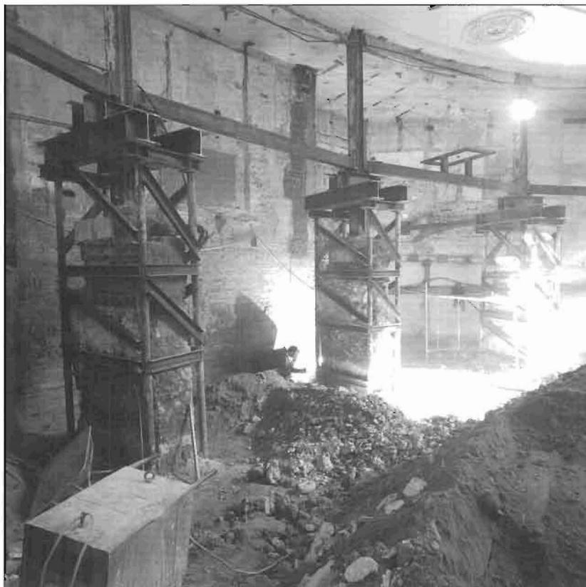
*Excavaciones. Andamio estabilizador muros medianeros y empalme pilares nuevos.*
