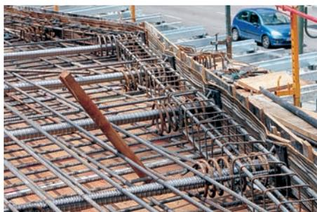
Figura 19. Primer plano del armado de los conectores de postesado en el canto de la losa del Teatro Principal.
