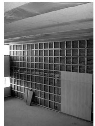
Figura 42. Tarima de madera de arce, sobre doble rastrel y apoyo elástico en aulas de danza.
