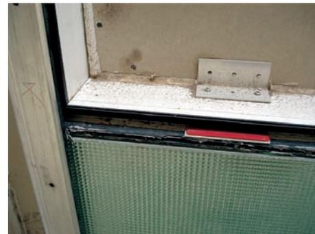
Figura 29. Imagen del vidrio de fachada y su sistema de fijación. Puede apreciarse la textura del mismo.
