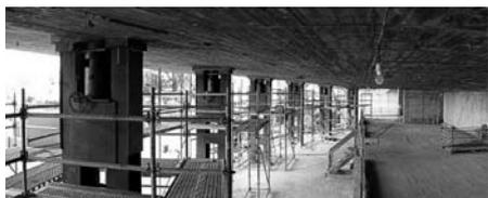
Figura 22. Fase 1: Pesaje de la estructura. Traspaso de la carga a los gatos.
