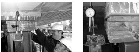
Figura 23. Fase 2: Ligera elevación y retirada de chapas.
